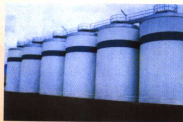
啤酒罐内壁喷砂、除锈、喷涂 T541。 外壁浇注聚氨酯硬泡绝热，外护板制安。
