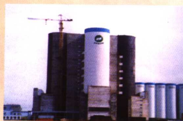
麦芽塔塔壁 851 聚氨酯防水涂膜、钢龙骨制安、现场喷涂、聚氨酯硬泡绝热、外护板制安。
