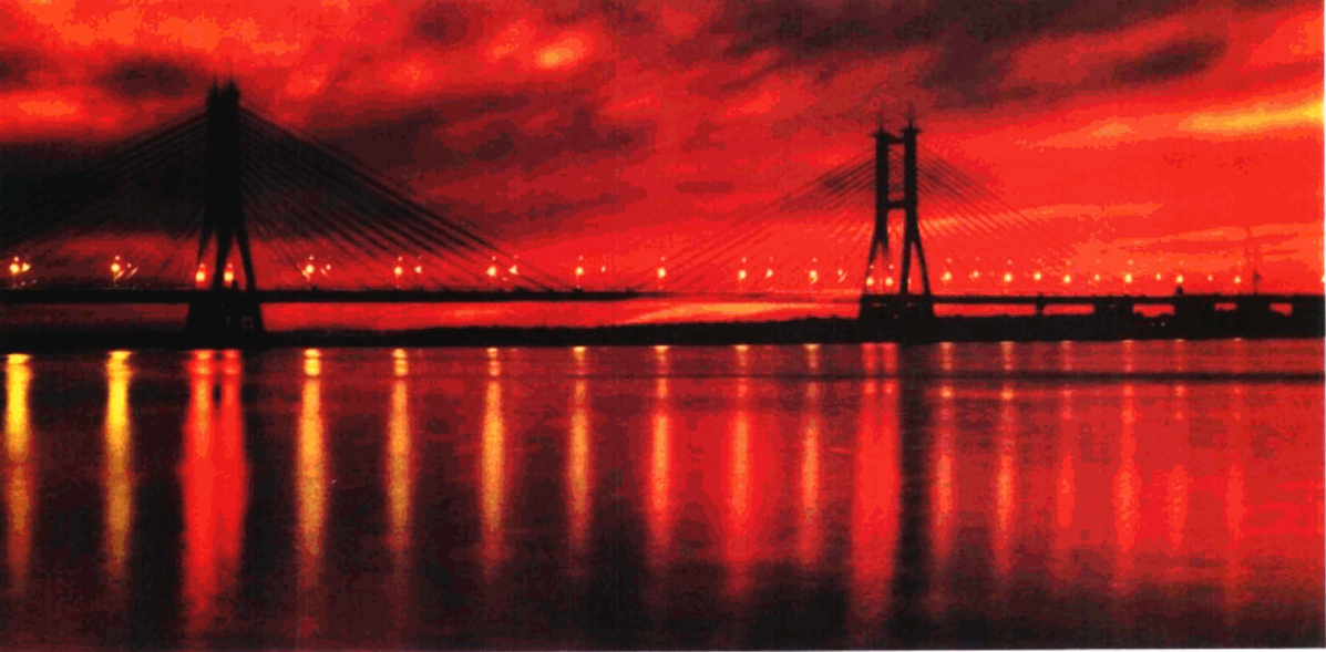
济南黄河公路大桥
