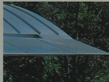
⑧ 通过在建筑弯曲的不锈钢屋顶下层镶嵌玻璃，设计师营造出一种没有重量感的特色，屋顶看起来就好像是悬浮于建筑之上的
