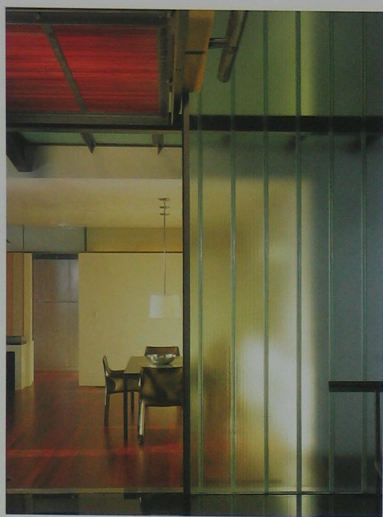
② 通过走廊看到的餐厅景观；半透明的槽形玻璃墙体与天桥在顶部相交。木质地板与手工厚制的石膏墙体增添了空间这个冷峻而现代的空间的丰富感
