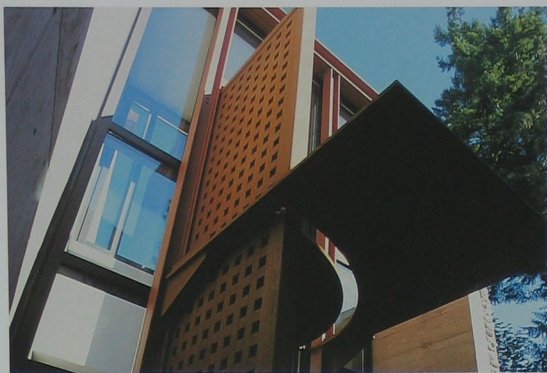
④ 屋顶/入口处的景观，展示了基地上原有建筑遗留下来 ⑤ 右侧的墙体与左侧的新建筑是如何联系的。相对于新建筑来说斜置的旧墙产生了一个俏皮的V型入口
