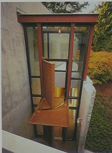
⑥ 从西侧观看，建筑与周围景观融为一体。西面主要活动空间的外墙上镶有玻璃，还设置了可通向花园和石砌空地的高大的旋转门，其中玻璃骨架使用的是未经加工与油漆的钢材。由钢柱和巨大的钢梁支撑，铜皮覆盖的屋顶向外延伸，遮蔽了建筑与花园之间的石砌空地
