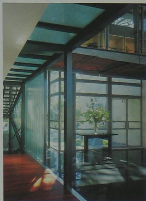
◎ 本图包括从室内看到的入口，在右侧，联系二楼两部分的天桥，右上方，还有左侧的楼梯塔。在楼梯的中间设置有半透明的槽形玻璃片。天桥上木质的书架与陈列隔板增添了楼上温暖的感觉；左侧通道上丰富的木质铺地也有相类似的作用
