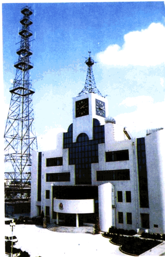
县邮电局程控电话楼。1994年竣工。
