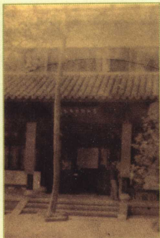
杭州虎跑寺之李叔同紀念室
