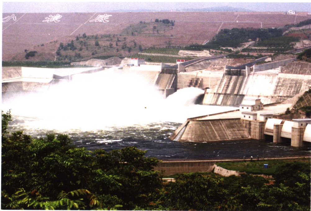
黄河小浪底水利枢纽工程。图片提供：中国图片库
