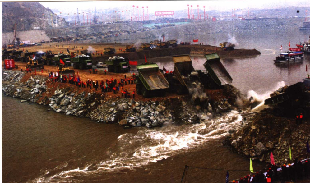
2002 年 11 月 6 日，长江三峡大坝合龙。图片提供：中国图片库
