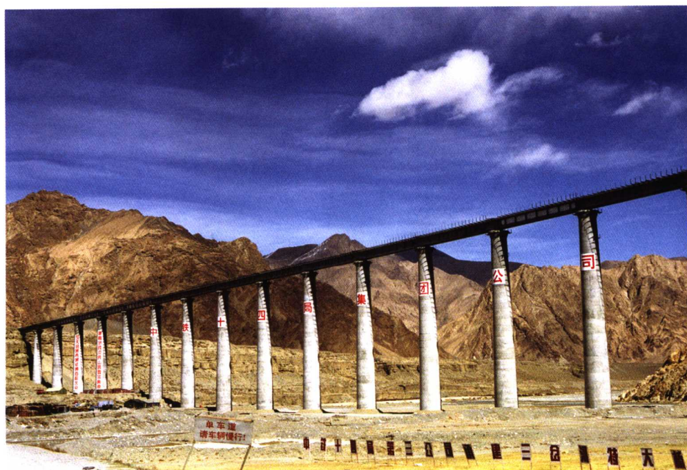
青藏铁路中最高的大桥——三岔河特大桥。图片提供：中国图片库
