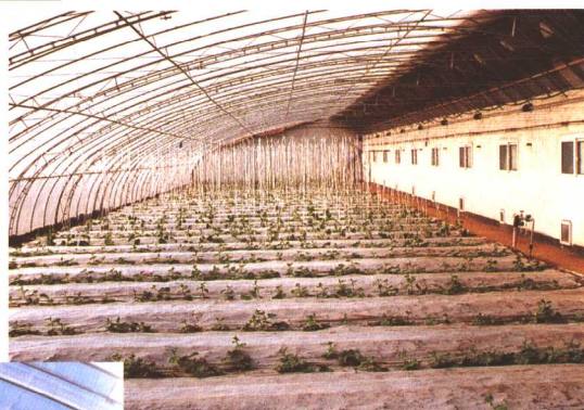
SD—III型日光温室无立柱钢架结构
