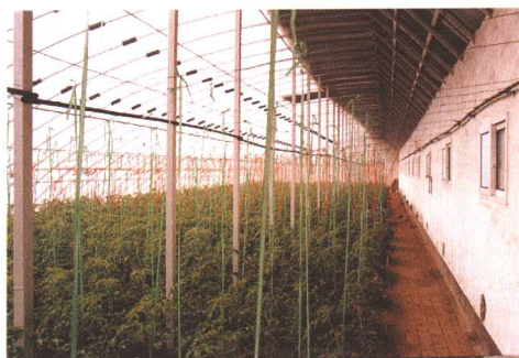
SD—Ⅲ型日光温室內景一排立柱，矩形钢管骨架
