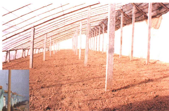
SD—II型日光温室竹木、水泥预制件结构
