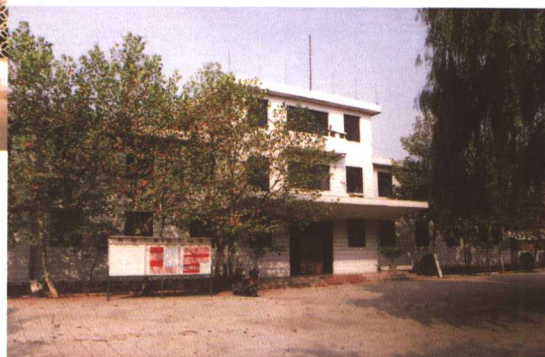
村（居）委办公大楼及大门
