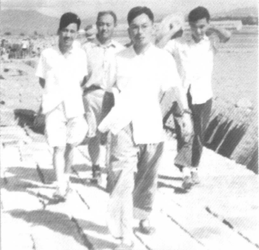
20 世纪 50 年代初叶飞视察厦门海堤工地
