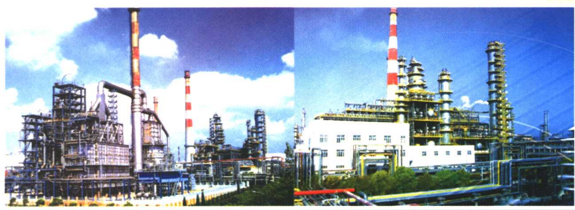
60万吨/年连续重整装置
