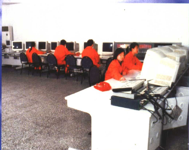
丁基橡胶操作室
