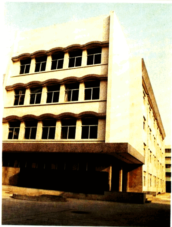
山东省档案馆 业务技术楼
