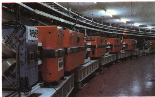
图四 储存环一部分。
