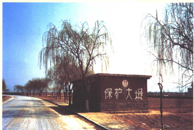
大堤上的防汛屋子
