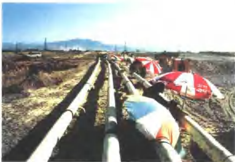
油气管道施工
