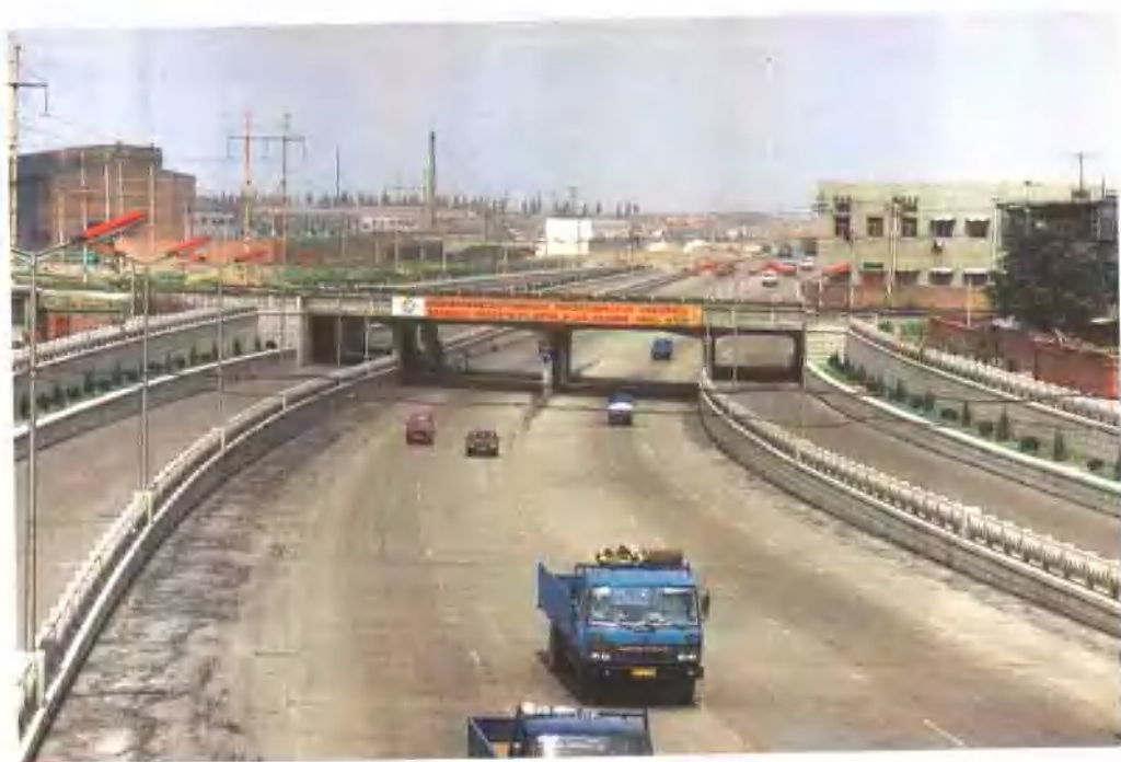
309 国道张店绕城线南定公铁立交桥
