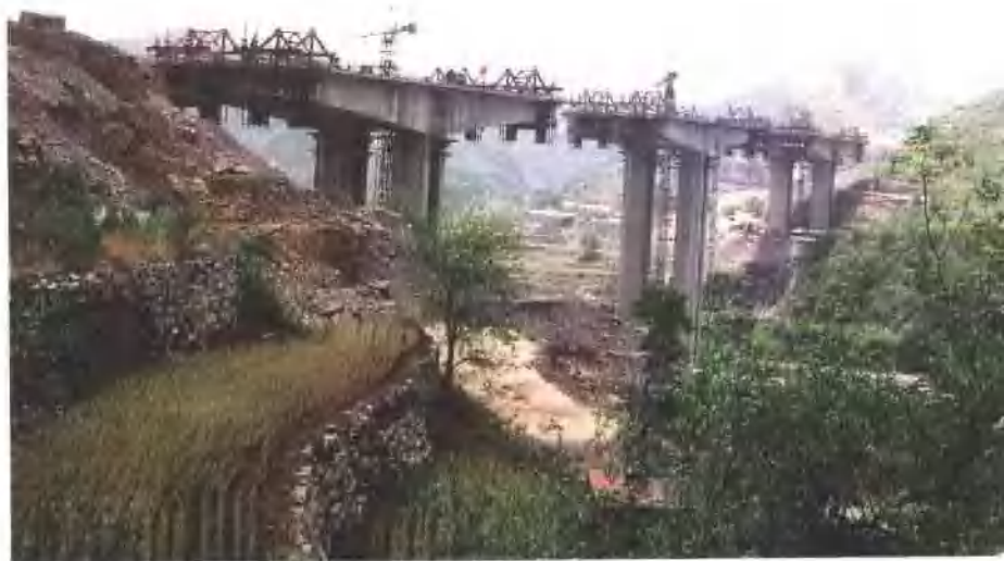
建设中的博莱高速公路。
