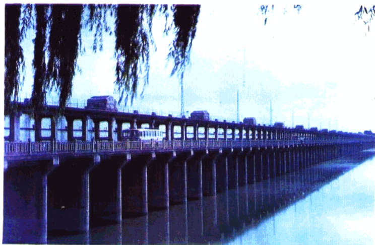
南四湖二级坝四闸
