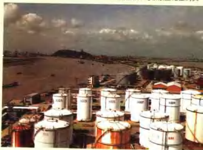
● 镇海港万吨级液压化工码头
