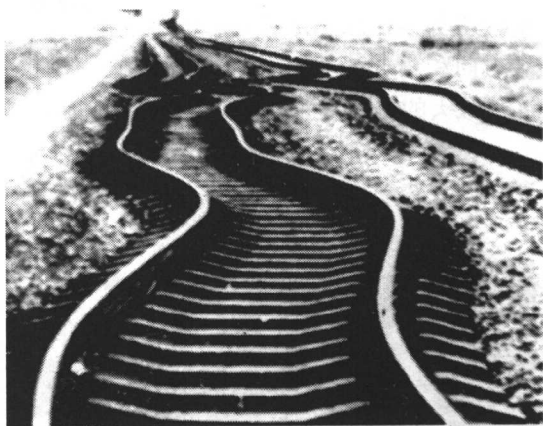
被地震强大的应力扭曲了的铁路
