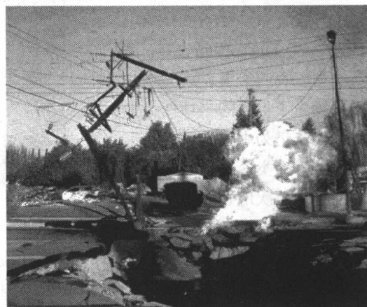
地震后，被巨大应力扯断的输气管道泄漏出大量天然气，并从路面塌陷处涌出燃烧
