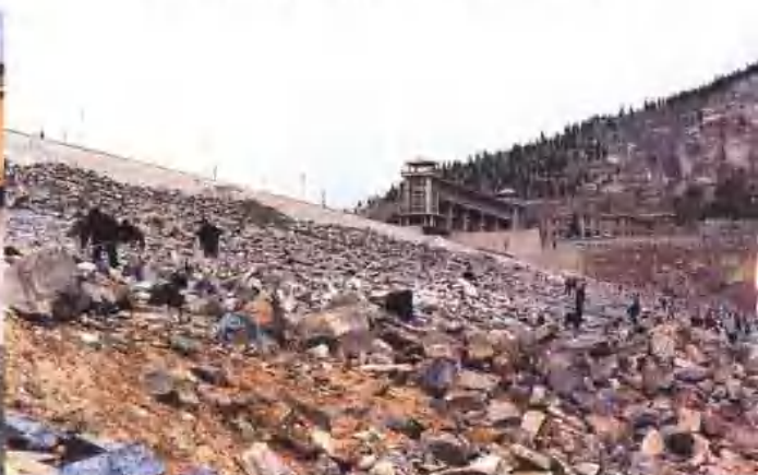
太河水库大坝除险加固工程工地
