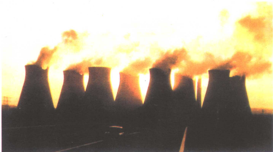
△ 以煤为燃料的火力发电厂外景。煤是一种不可再生资源，储藏量是有限的
