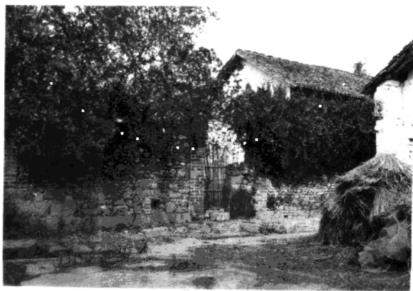
罗城龙 岸 石下株村柳州日报总社 旧址（原房屋已损坏）。
