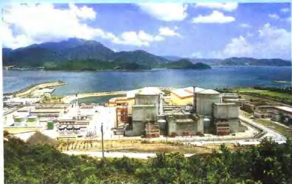
我国最大的核电站——深圳大亚湾核电站：装机容量 2 \times 98 万千瓦。
