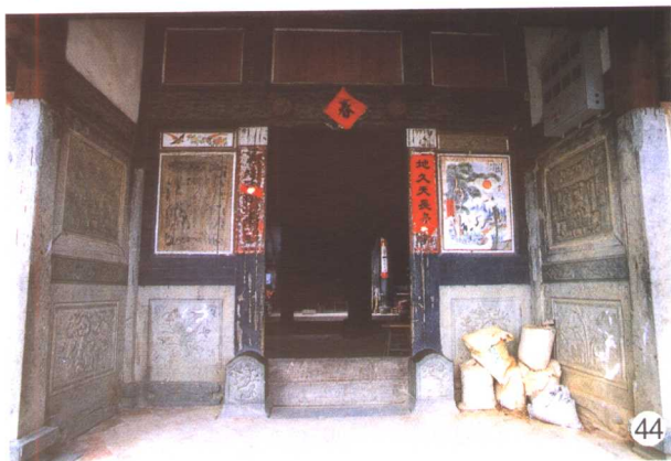
凹斗式大门坦构造格式 (盖尾连宅)
