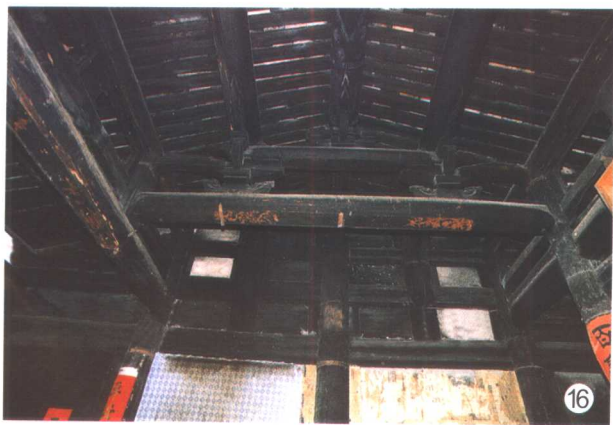
林氏古民居厅堂梁架结构 (穿斗与抬梁混作)
