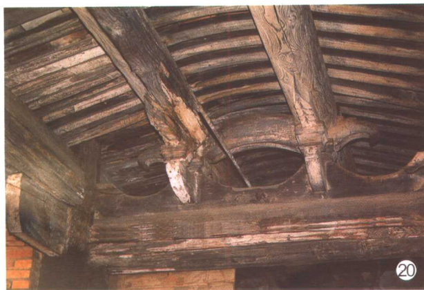
大宗伯第廊檐梁架结构
