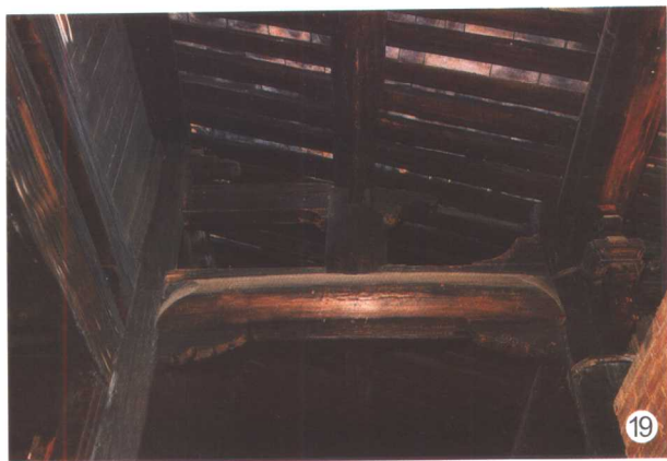
御史大夫第廊檐梁架结构
