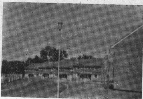
图1—6 用无砂大孔混凝土建造的二层住宅
