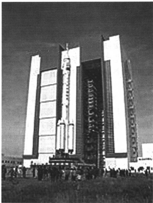
发射场总装测试厂房
