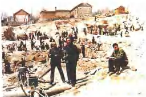
一九八八年，雪野水库桃流鼻坎 工程施工现场。
