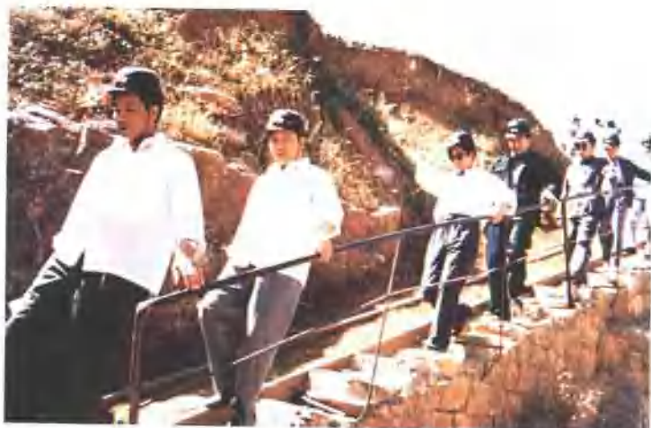
1986年，副省长马忠臣（左二）、泰安市委书记宋法棠视察红埠岭调水工程施工现场。
