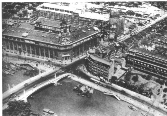
图1-3-2 四川路桥和邮政总局 这里是四川南路的起点，最右方为公济医院（The General Hospital）当时是上海最大的医院（上世纪三十年代）
