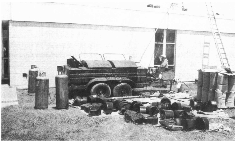
图 1.2 屋面作业中的熔锅
