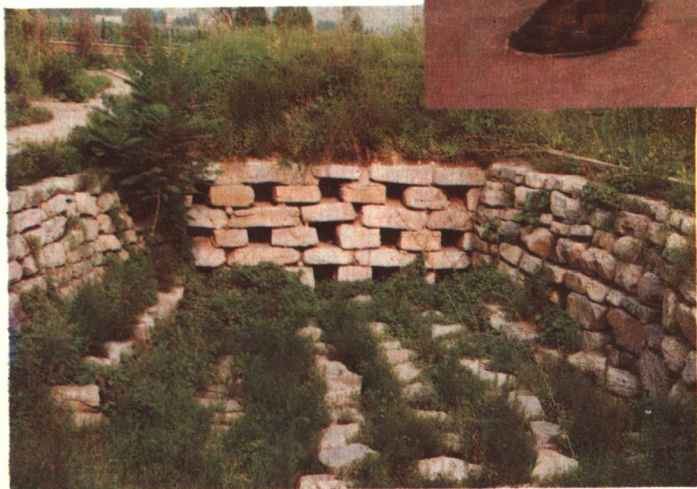
排水道口 临淄齐国故城
