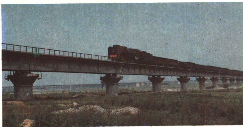
胶济铁路淄河大桥
