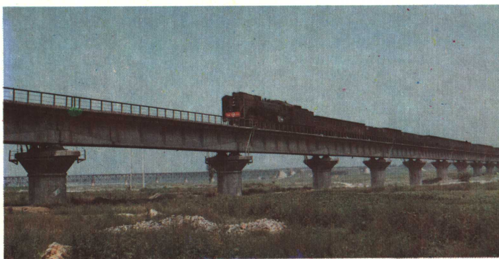
胶济铁路淄河大桥
