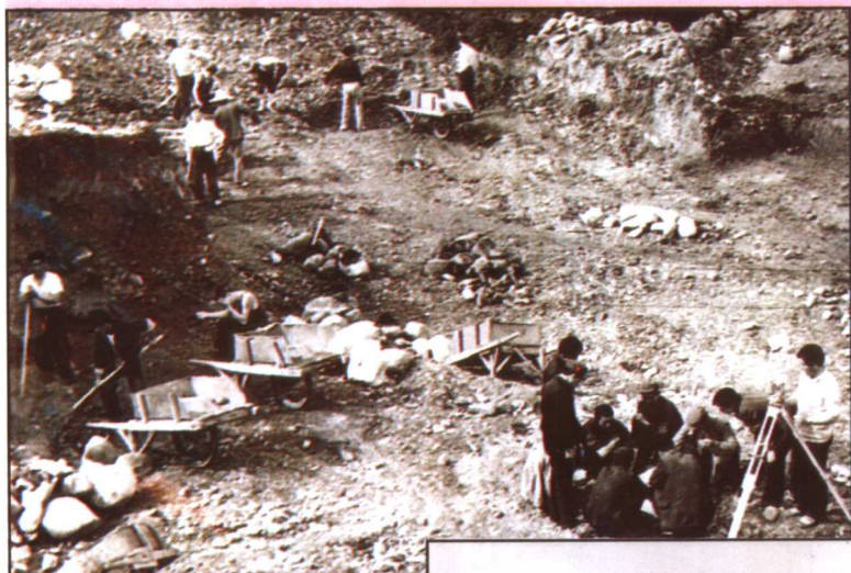
水库施工现场
