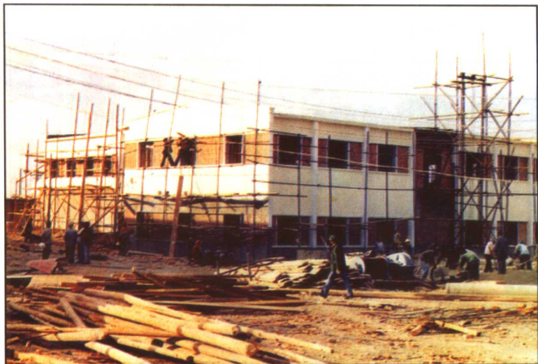
承建克拉玛依第二净化水厂
