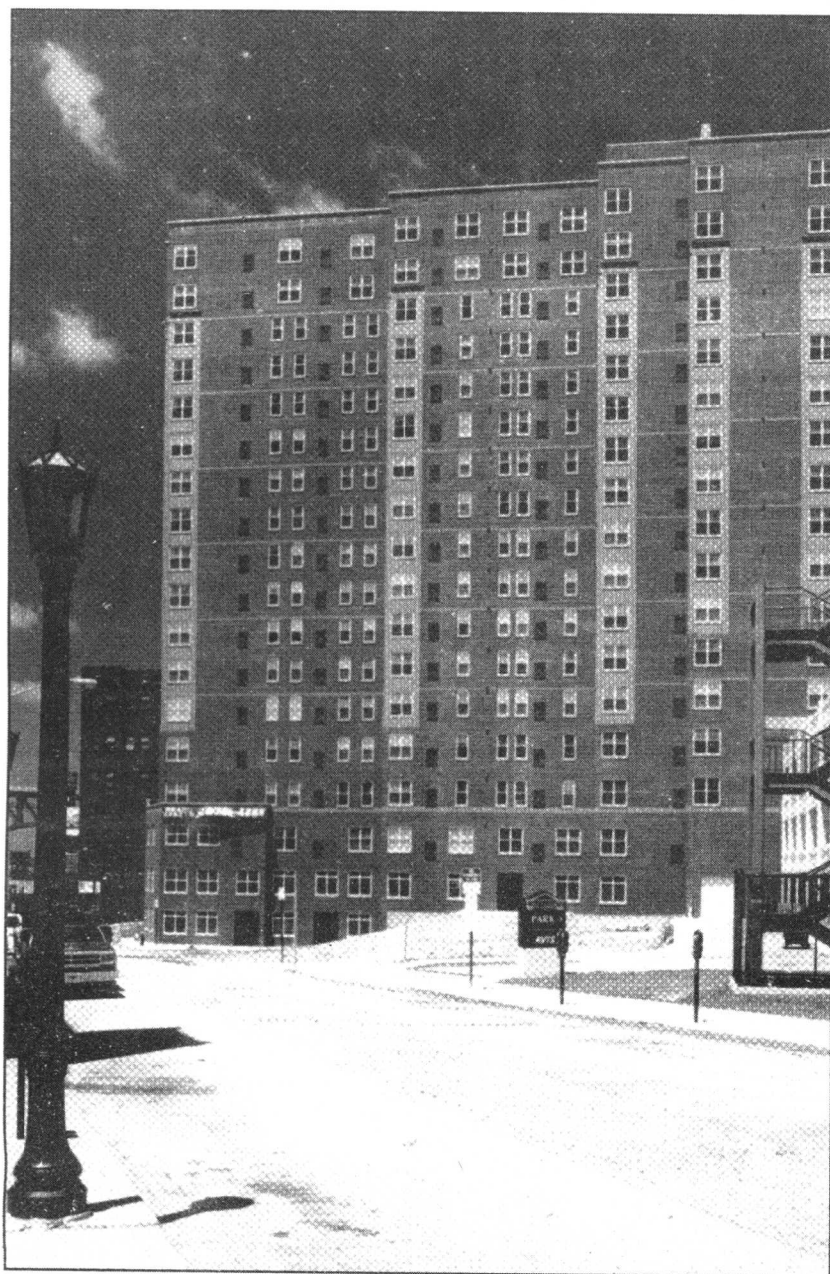
17层的 Crittenden Court 公寓建筑是俄亥俄州 Cleveland 市(也许也是整个美国中部)最高的承重砌体结构建筑。该建筑建成于 1995 年,是砌体结构建筑的里程碑。整个建筑用掉 30 万块砖、50 万块砌块、8000 包砂浆、5000 袋灌浆水泥。照片由 Hach 与 Ebersole 工程咨询公司(俄亥俄,Cleveland)Steeve Ebersole 先生惠允。
