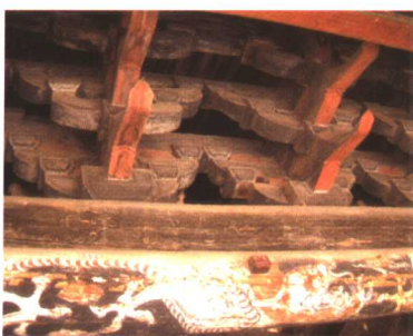
稷山县南阳村法王庙戏台斗栱
