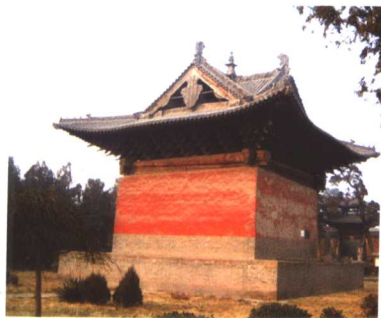
临汾市东羊村东岳庙戏台背面
