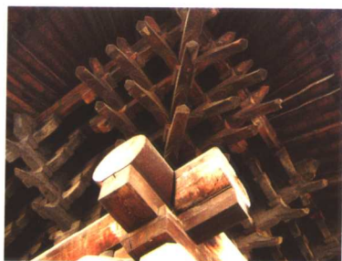
临汾市东羊村东岳庙戏台转角斗拱
