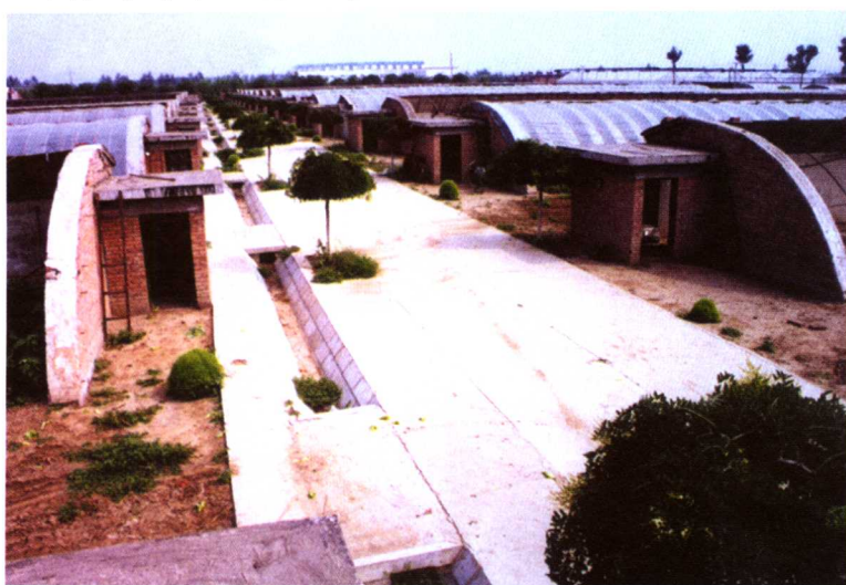
大兴区长子营示范区园区全貌
