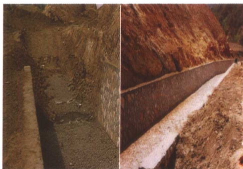
排洪渠内的违规弃渣得到清理
