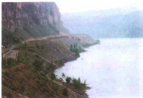
万家寨水库下游左岸渣场治理工程
