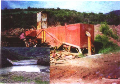
生产废水经沉淀箱后到下级沉淀池进行再处理
