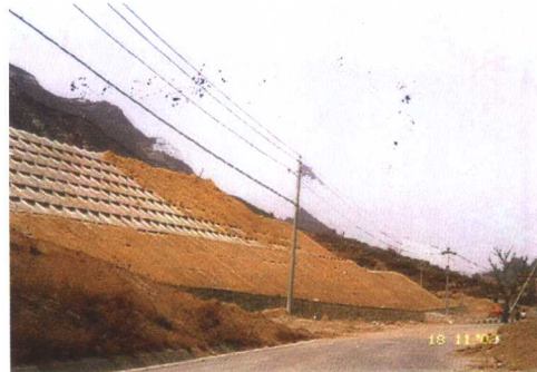
呼延渣场治理工程
