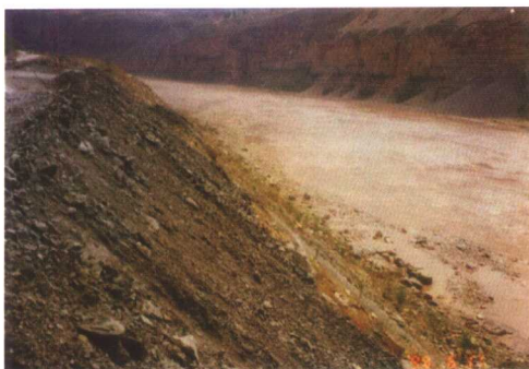
违规弃渣使河道变窄且引起水土流失
