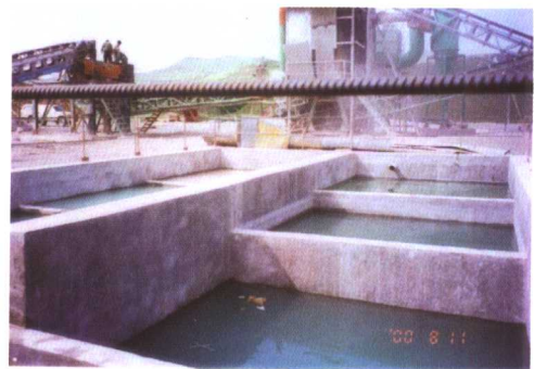
承包商新增的废水沉淀池
