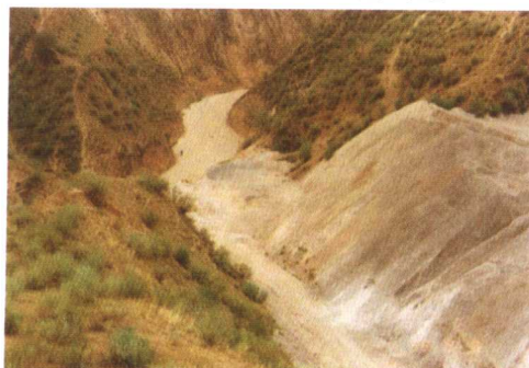
违规弃渣造成严重水土流失
