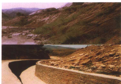
修建排洪渠防止弃渣水土流失
