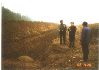
检查 PCCP 管安装工地
