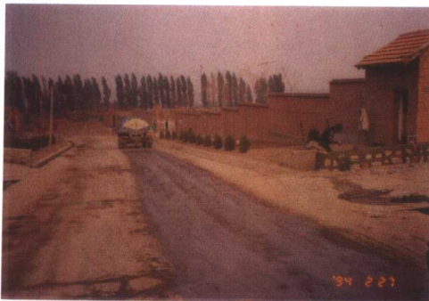
洒水车定时洒水减少施工道路扬尘
