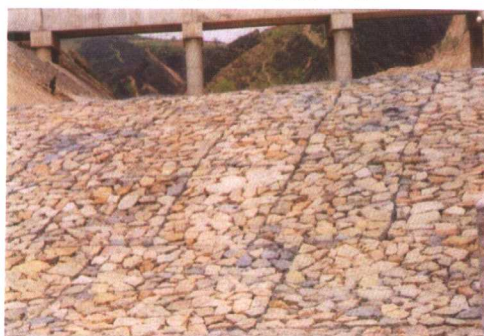
南干龙须沟已筑好的挡水坝
