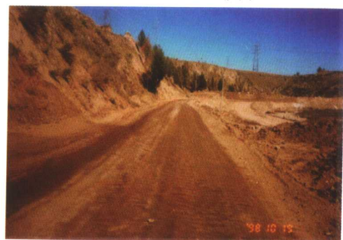
洒水后的施工道路
