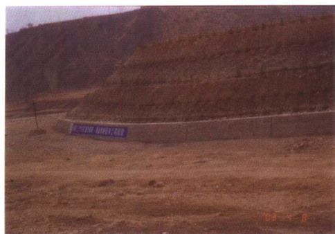
岩头寺渣场的绿化工程
