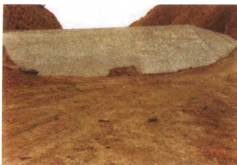
总干马家山渣场砌护平整
