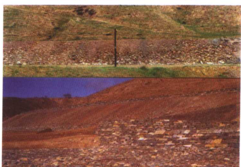
修建挡渣墙防止水土流失
