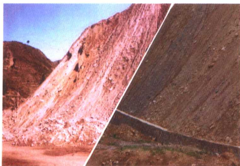
修建临时挡渣墙防止弃渣水土流失
