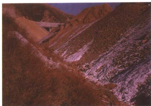
违规弃渣堵塞行洪通道
