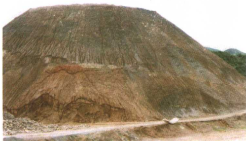
弃渣无防护已造成严重水土流失
