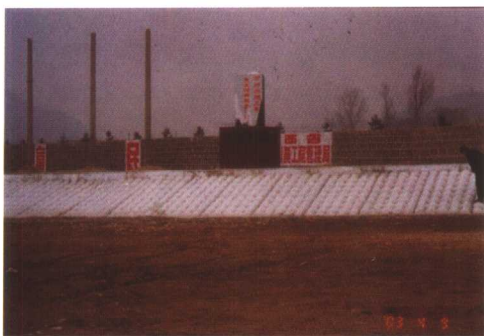
南干 7 号 洞出口已治理好的汾河护岸
