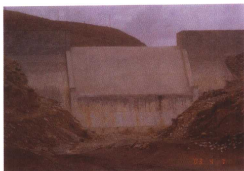
大岔沟渣场治理工程
