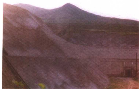
南干 5 号 洞出口边坡处理情况
