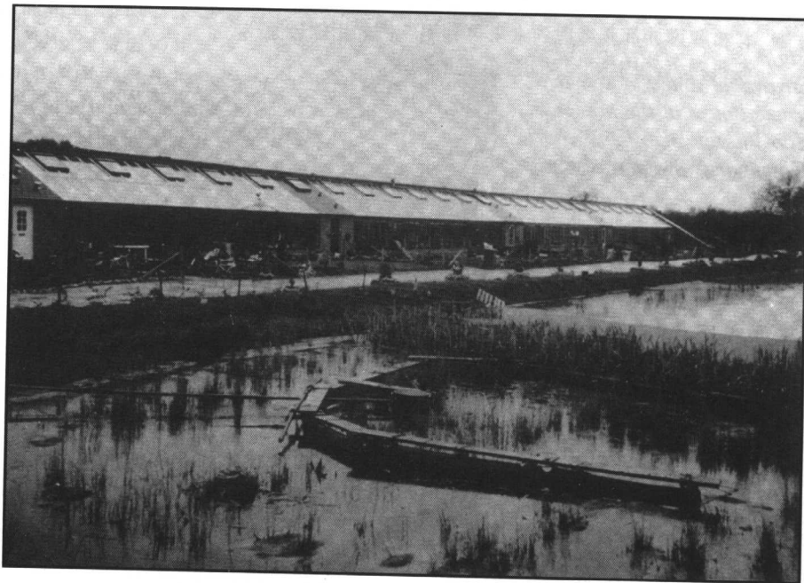
图6 Hockerton房屋工程,诺丁汉郡
