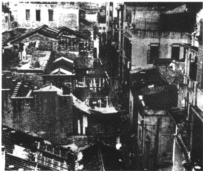
怀远驿的遗址，但当年的建筑早已损毁。
