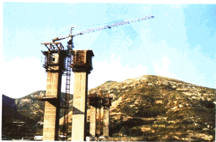
建设中的樵岭前特大桥
