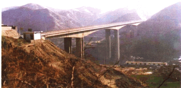
山东公路第一高桥—樵岭前特大桥
