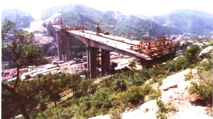
樵岭前特大桥采用挂篮工艺进行施工
