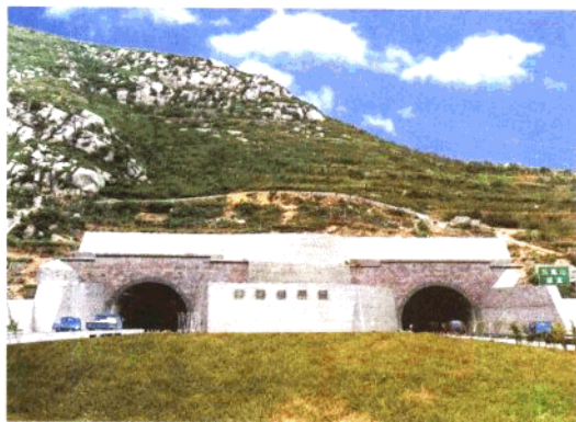
山东最长的公路隧道—凤凰山隧道
