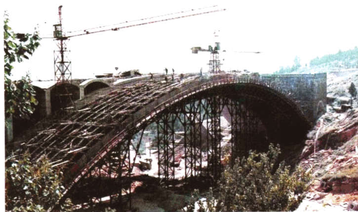
利用钢拱支架进行施工的乐疃特大桥
