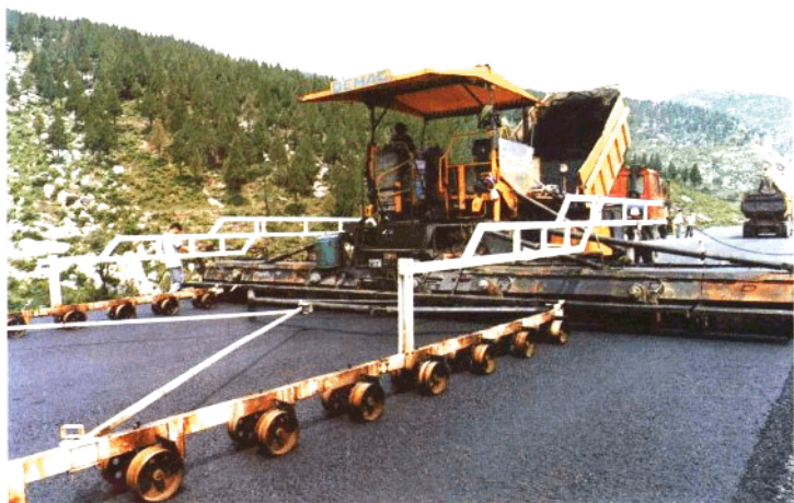
博萊路路面施工情景
