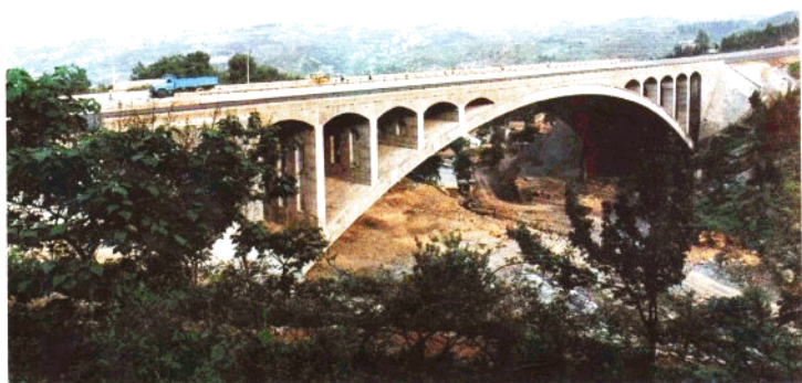
山东第一座一跨 100 米箱形拱桥—乐疃特大桥
