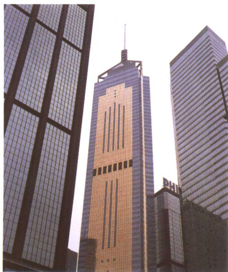
图4 隐框玻璃幕墙
