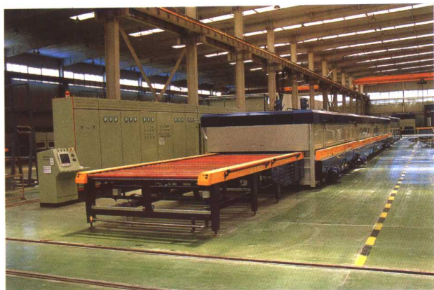
图1 钢化玻璃生产线
