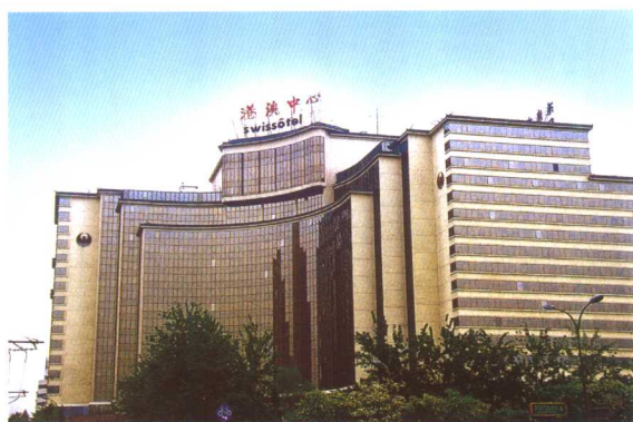
图2 明框玻璃幕墙
