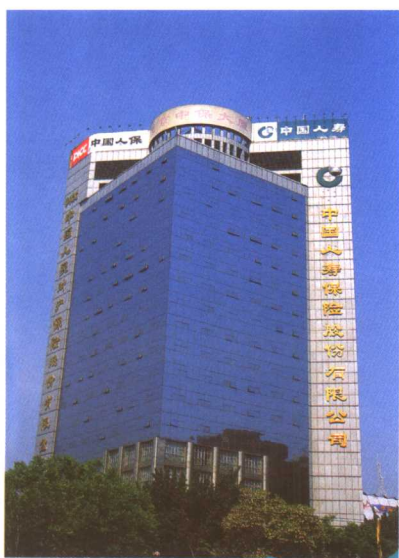
图6 竖隐横框玻璃幕墙
