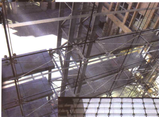
图9 杆(索)式玻璃幕墙
