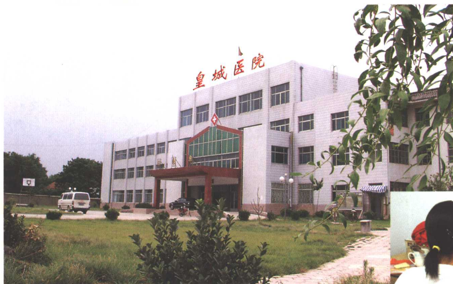
皇城医院病房大楼
