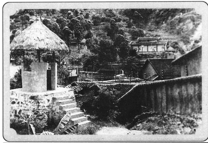
渣滓洞看守所岗亭
