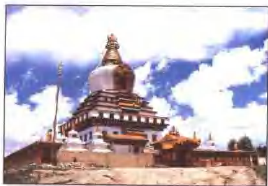
阿坝县格尔登寺大佛塔(州文管所提供)
