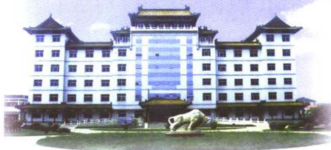
戴南镇人民政府办公大楼
