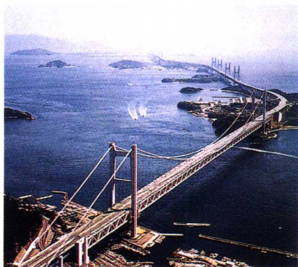
日本跨海铁路桥
