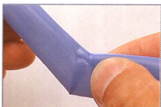
14 挤压,使折角弹开,卡住嵌紧。
