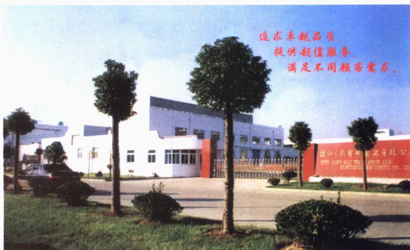
镇江三维电器有限公司
