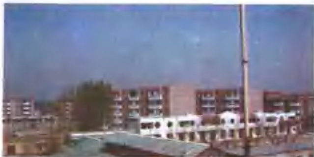
→ 杨庄住宅小区
