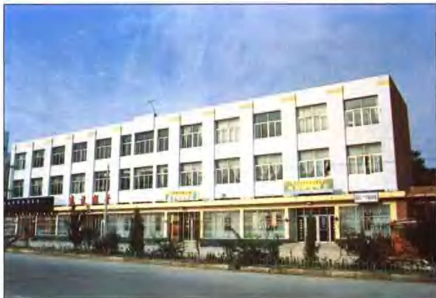
商河县人民武装部办公楼
