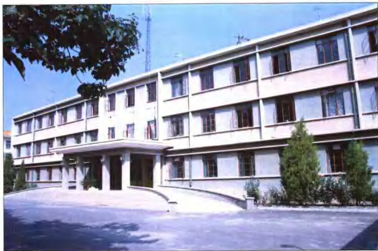
商河县委办公楼
