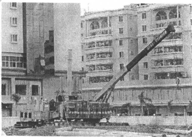
图 1-1 静压预应力混凝土管桩施工
