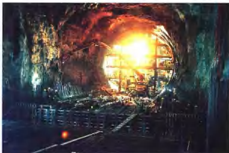
三条直径为14.5米的导流洞混凝土衬砌采用钢筋台车，钢模台车一条龙施工
