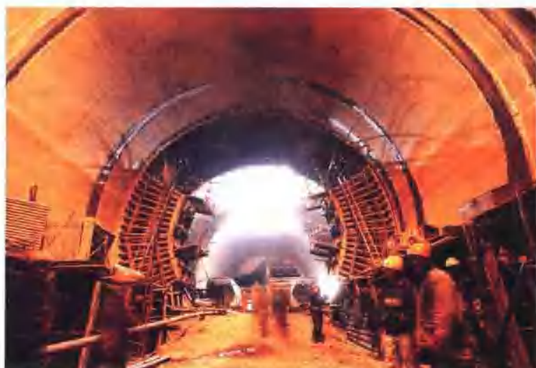
世界最大孔板泄洪洞的孔板环施工
