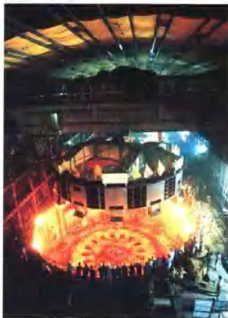
发电机定子吊装
