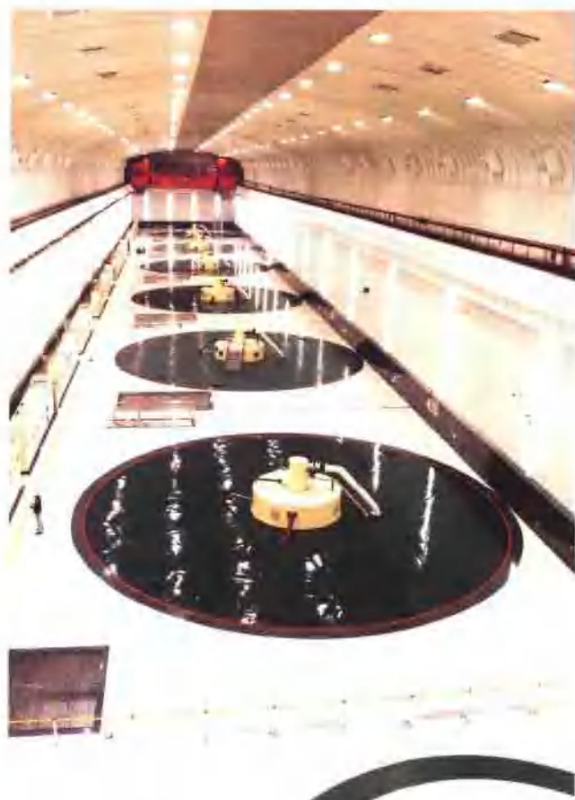
地下发电厂房(局部)
