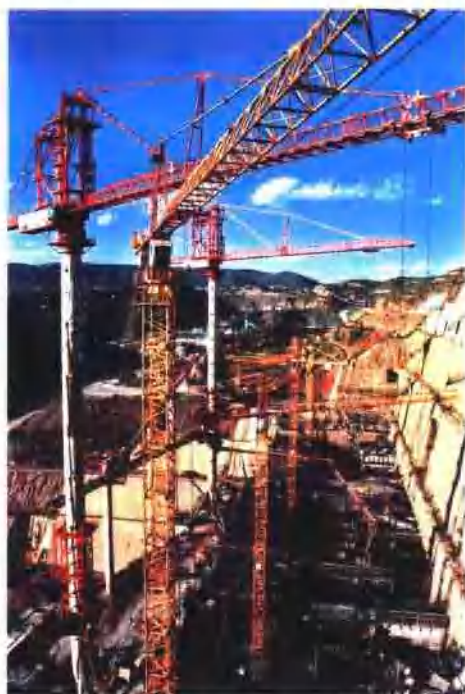
高度机械化施工
