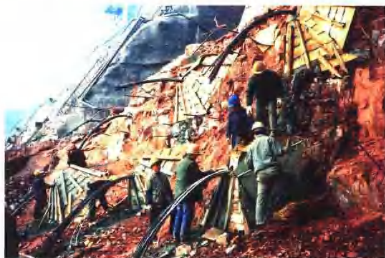
高边坡锚索群安装
