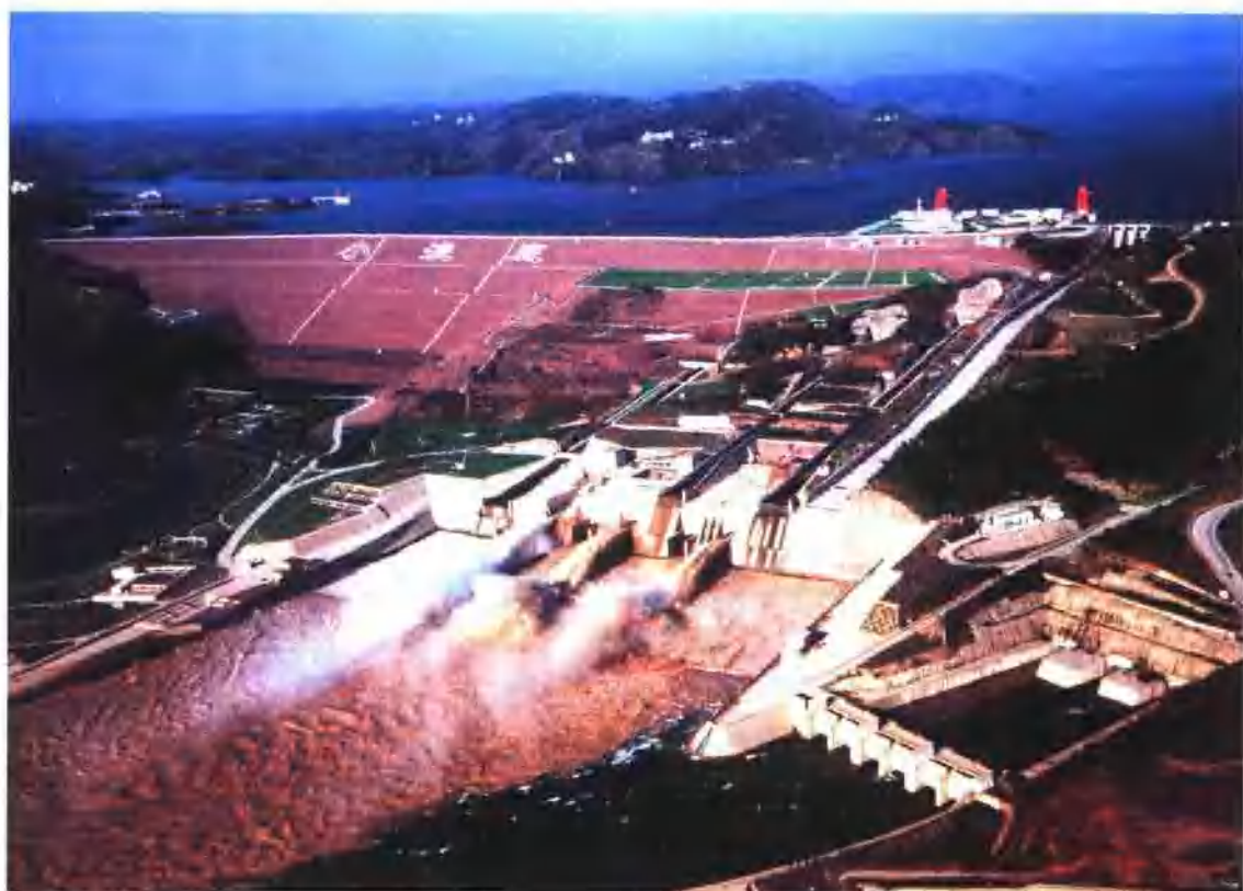
鸟瞰小浪底水利枢纽全貌
