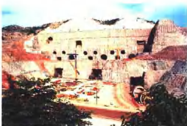
泄洪工程进水塔浇筑前洞群面貌
