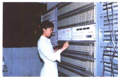
8. 布控 140 线用户电报低速数据交换机 Wired-logic controlled 140 line telex and low speed data switching system.
